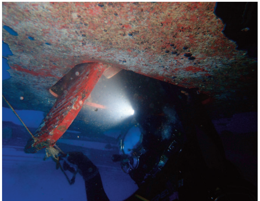
El buzo que realice una inspección clasificada debe estar familiarizado con la estructura de un buque. - Trident U.S.
