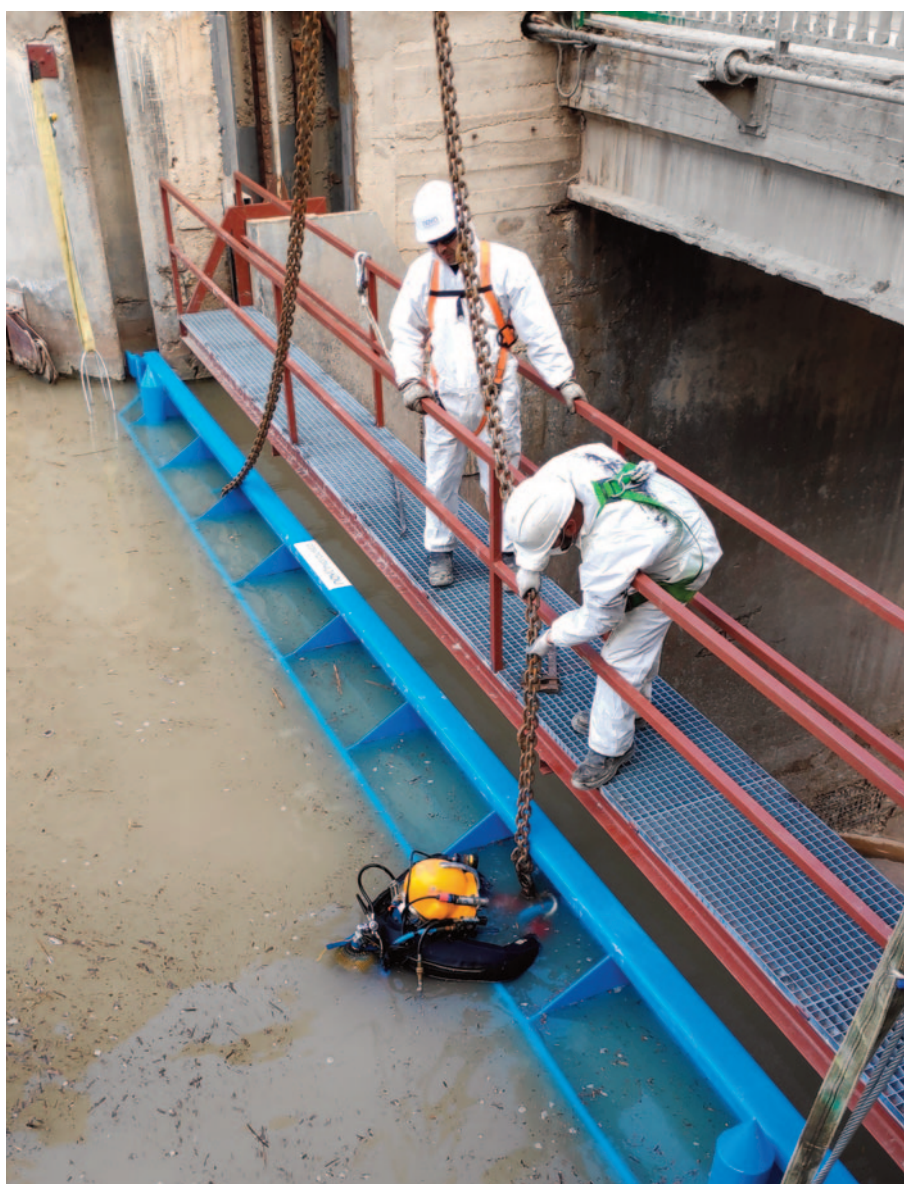
Asistencia para la colocación de una compuerta en una presa. Servicios Técnicos Subacuáticos - España.
