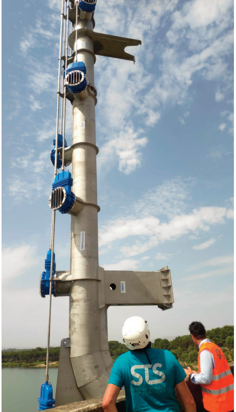
Torre de toma de agua de un embalse para recoger recursos a diferentes profundidades. . STS España
