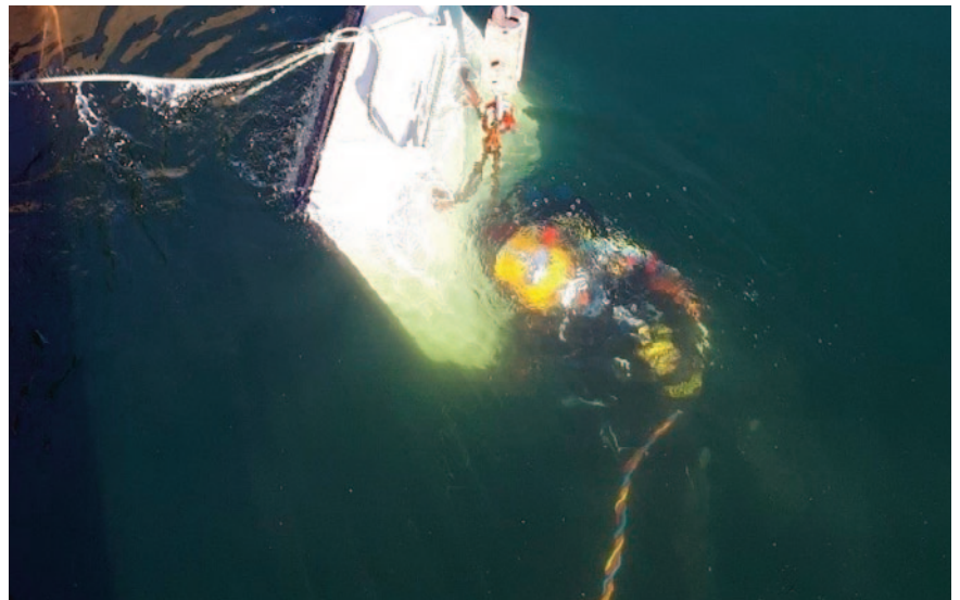
Arriba, buzos en una plataforma flotante con una embarcación de apoyo, para realizar trabajos en el interior de una torre de toma de agua. Abajo, maniobra de extracción de un escudo para el taponamiento de un desagüe. STS España
