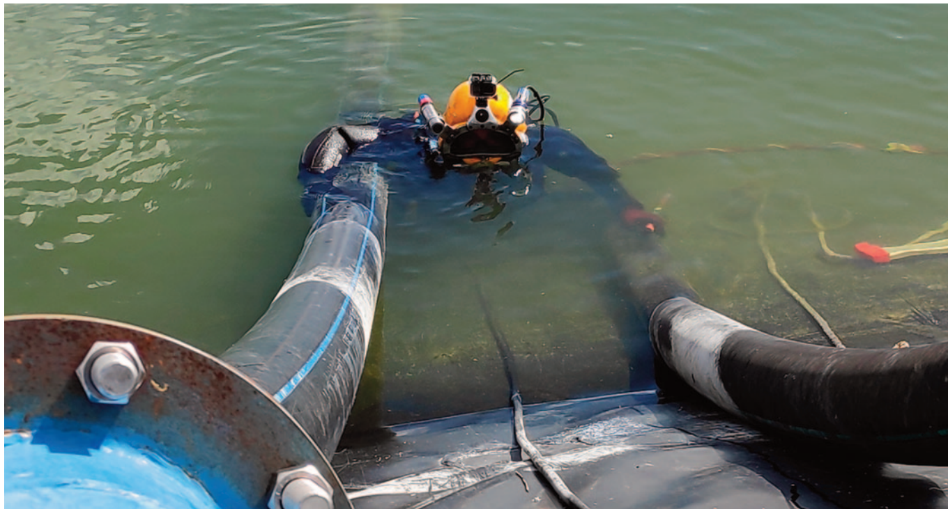
Buzo durante la Inspección de tuberías de aspiración en una balsa española Servicios Técnicos Subacuáticas - España.
