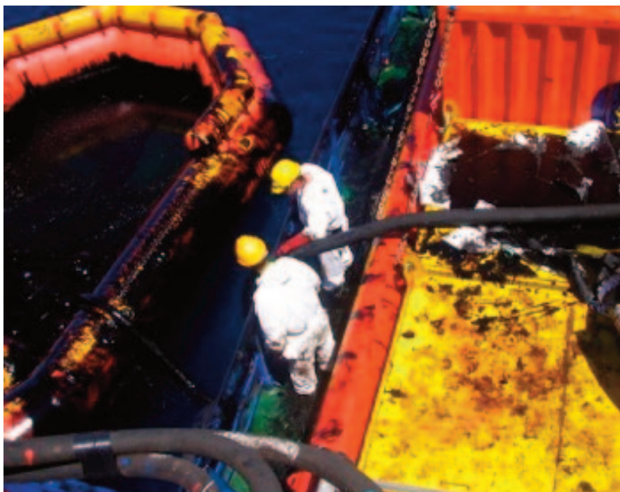
El operativo de lucha contra la contaminación, extrae con una bomba el fuel de la bolsa de contención. Foto: Luis Torcidas
