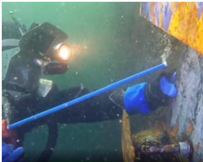
Imagen 1: Formación de hidrógeno por electrólisis . Nordic Marine Service A/S Dinamarca
